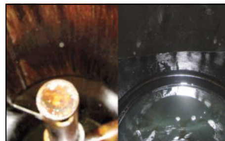
Depósito contaminado limpio
